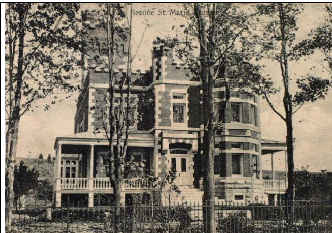
Photo 1 : Façade principale, vers 1910
